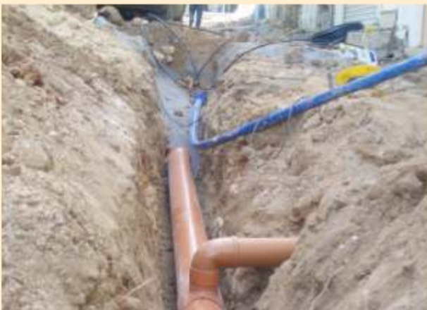
Αντικατάσταση δικτύου ύδρευσης και κατασκευή δικτύου αποχέτευσης Αρκαλοχωρίου
