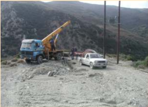
Εργασίες εξοπλισμού γεωτρήσης
