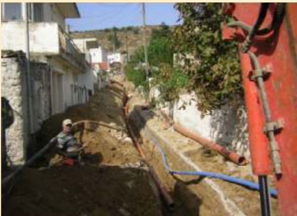
Επέκταση - κατασκευή δικτύων ύδρευσης & αποχέτευσης Σκινιά
