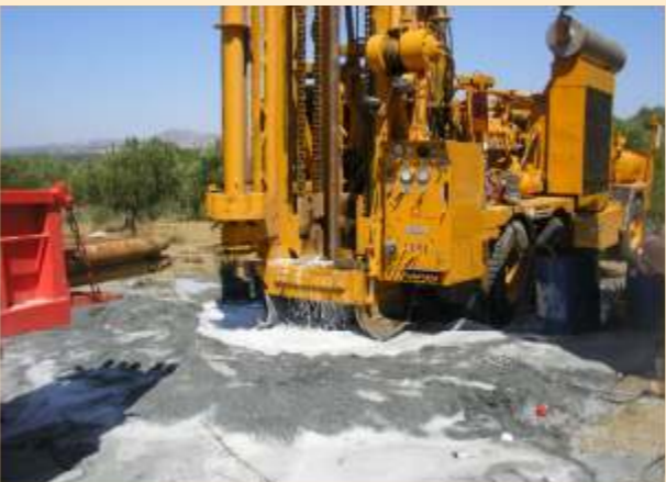
Ανόρυξη γεωτρήσης Λαγούτας
